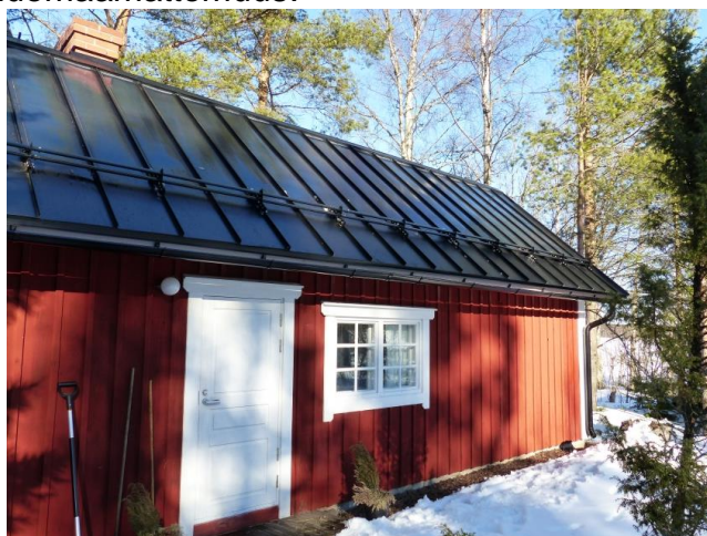
Kuva 74: Tehdasasennettu peltinen aurinkokatto vanhassa talossa (Sannanranta, Kokkola). Lähde: http://www.virtesolar.fi/case-sannanranta-kokkola
