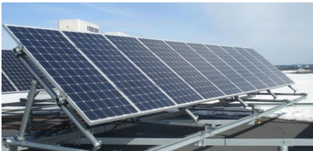
Kuva 53: Aurinkopaneelit asennettuna tasakatolle pystytelineisiin. Kuva: Finnwind Oy.
