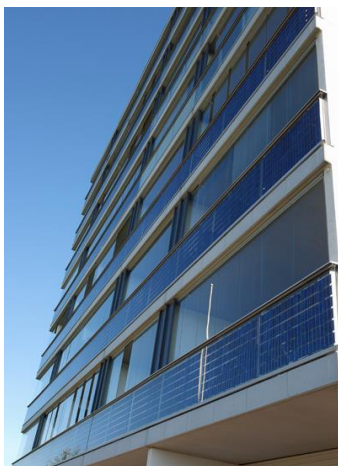
Kuva 73: Parveikkeisiin kiinnitettyjä aurinkopaneeleja Helsingin Viikissä: voimalan teho 24 kW. Lähde: http://www.aurinkoenergia.fi/aurinkoenergiaa.html
