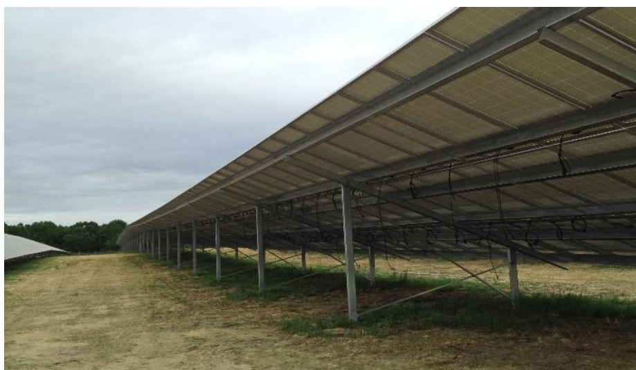
Kuva 82: Iso maalle rakennettu aurinkovoimala kiinteäkulmaisilla telineillä.
