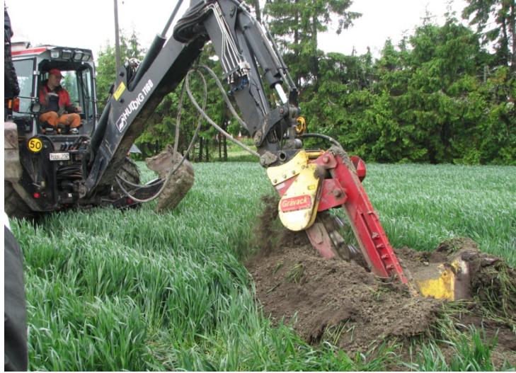
Kuva 4. Kaapelin asennuskaivannon tekoa ketjukaivurilla.
