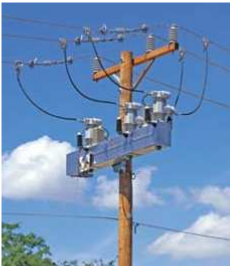
Kuva 62. IntelliRupter® PulseCloser (S&C Electric Company 2006)
