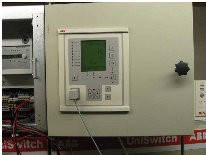
Kuva 39. REF-sarjan rele, jossa on häiriötallenninyksikkö.
