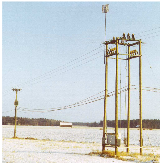
Kuva 5.11 Kauko-ohjattava erotinasema.
