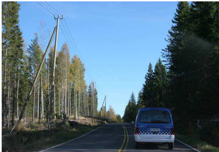
Kuva 5.5 PAS-tekniikalla toteutettu johto-osuus tien varressa.
